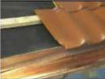
подкровельной гидроизоляционной пленки. После плотной укладки подкровельной мембраны монтируется гребень свеса из перфорированного металлического профиля. Перфорация уголка должна иметь 62 %, что при высоте в 65 мм дает 400 см впуска воздуха на погонный метр.
