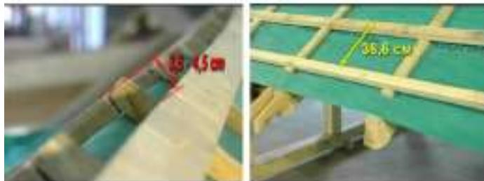
Необходимо отметить на коньке контрбруса место размещения подконочковой рейки. Расстояние от верхней точки до начала этой рейки зависит от угла ската кровли (35-45 мм). Когда длина ската кровли не превышает 6 метров применяется контрбрус толщиной 24 мм, при длине ската до 12 метров применяется контрбрус толщиной 28 мм, при длине ската кровли более 12 метров применяется контрбрус толщиной 40 мм. После обозначения места закрепления последней рейки считая от конька
