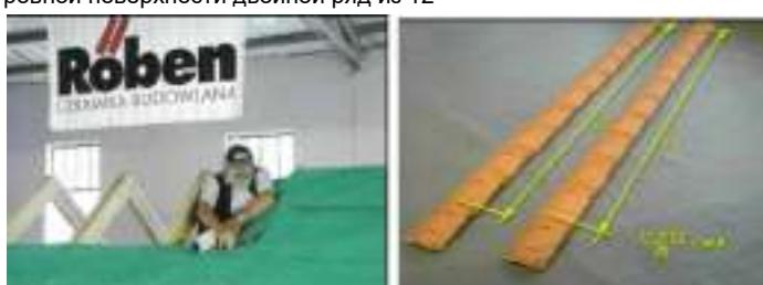
черепиц. Укладывать необходимо верхней стороной вниз вертикально на смещение и размещение так, чтобы передние складки сцеплялись. Размеры на смещение и размещение между первой и последней черепицей суммируются и делится на 20. Средняя величина реек составила 366 мм. Максимальный допуск к расположению реек погрешность около 3 мм. Поэтому допускается шаг обрешетки выполнять в диапазоне от 366 до 369 мм. Затем на
