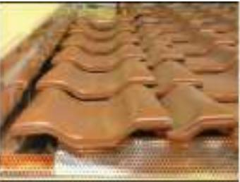
случае необходимости применяется половинчатая черепица перед укладкой двухволнистой черепицы. После монтажа верхней планки примыкания укладку каждого ряда закрывает двухволнистая черепица. Это влияет на эстетику отделки ската кровли.
