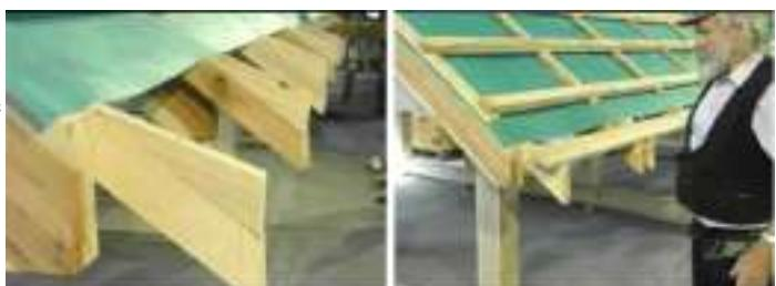
Данный вариант используется при условии увеличения длины стропильной ноги. На нижних частях стропил с каждой стороны крепятся удлинения в виде кобылок, поверх которых устанавливаются клины, впоследствии на которые будет закреплен навесной брус. Далее к нему монтируются держатели желоба,
