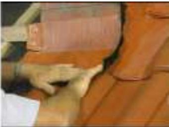
свинца. В случае необходимости черепица дорезается и укладывается при дымоходе. Кромки этой черепицы должны быть обработаны вместе со стыка обработок и самоклеящихся
