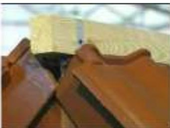
см. Для эффективной вентиляции подконьковой черепицы применяется уплотняющая лента с вентиляционными отверстиями. Также допускается использовать вентиляционные решетки. Под коньковую черепицу рекомендуется применять ленты, изготовленные из алюминия и свинца. Затем укладывается конько-
