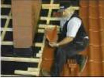
черепице, на которой находится ступень, необходимо сбить горизонтальный замок, благодаря чему получается правильная посадка ступеньки безопасности. Верхнюю черепицу требуется подогнать к ступеньке безопасности через удаление части замка. Примыкание дымохода требуется выполнять с особой старательностью. Для обработки дымохода применяется рифленый самоклеящийся материал на основе алюминия или
