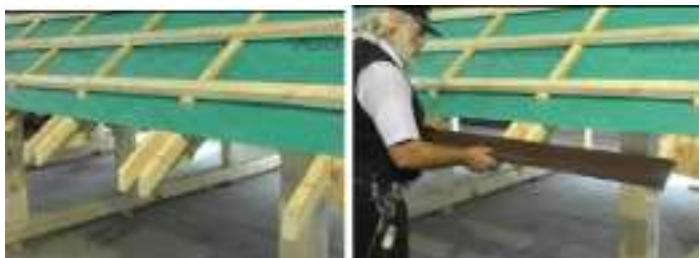
Данный вариант устройства карнизного свеса используется при небольшом угле ската кровли. В стропилах делаются прорези в которые монтируется карнизная планка. Затем набивается контрбрус для свеса и монтируется гребень свеса высотой 60 мм.
